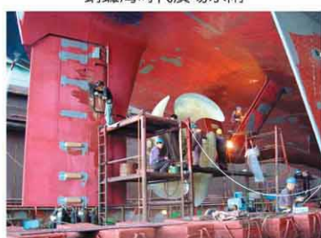
Machinery Repair 機械維修
